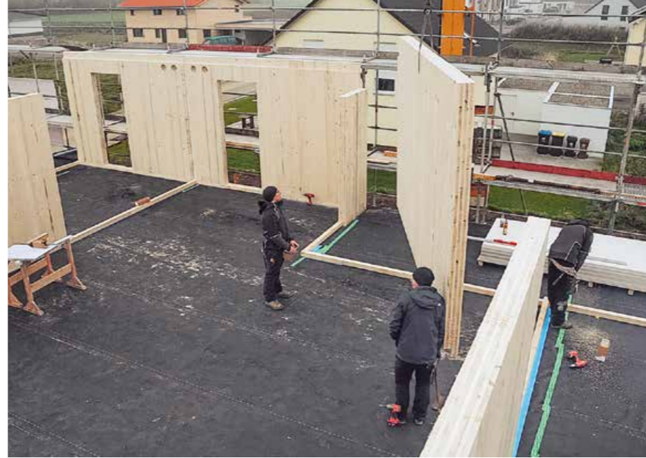
◀ Montage einer Wohnungstrennwand im OG. Rechts die Balkone der beiden kleinen Wohneinheiten
