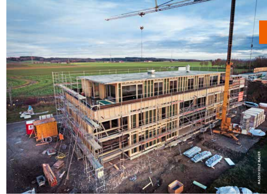
▶ Rohbau mit vorgesetzten Holzrahmen für die Einblasdämmung
