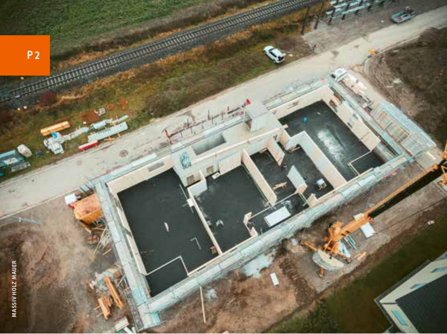
◀ Die vier Wohneinheiten mit Trennwänden und ersten Innenwänden aus der Vogelperspektive
